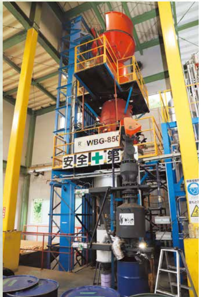
バイオマスガス化発電を行う機械の一部。機械の下部からバイオ炭が排出される ＝南部町内
