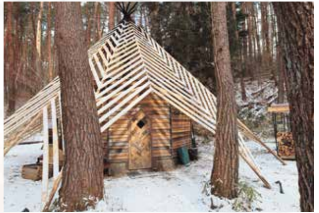
アカマツ林の中にある サウナ設備
